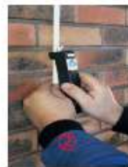
Exemple d'application : Ouverture d'un câble distribution intérieur
