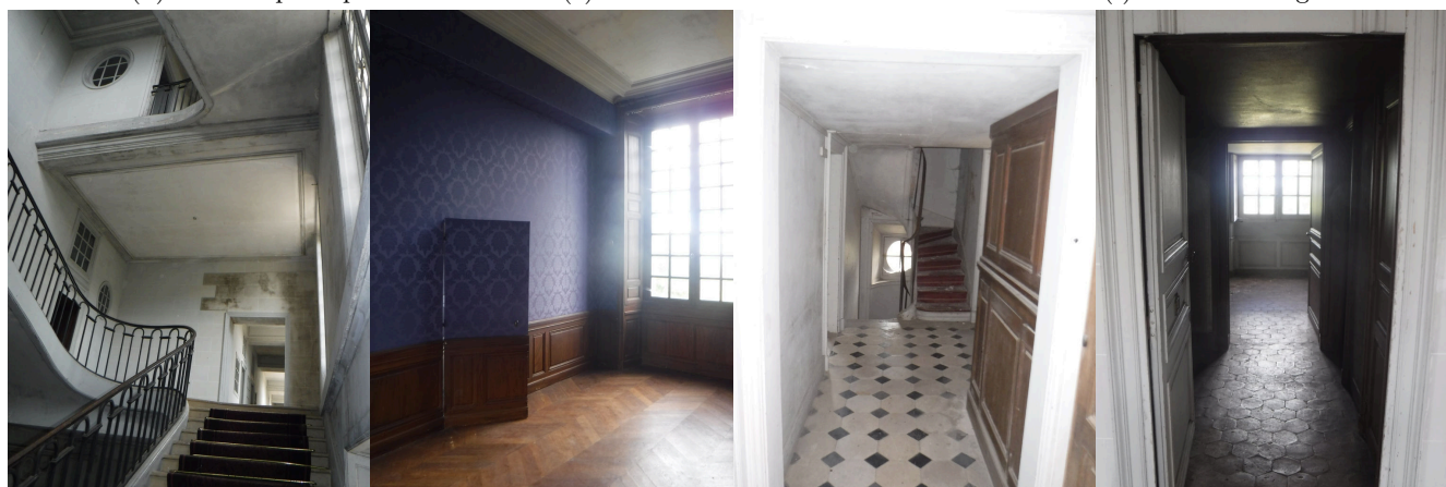
(g) Escalier principal
