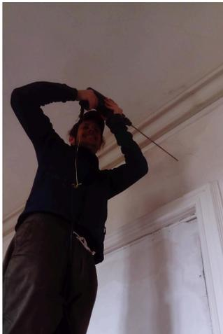
(d) Percée dans le mur du faux plafond.
